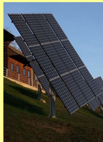
Sončni paneli sledilne elektrarne (Velika Kostrevnica; Šmartno pri litiji - Ludvik Zaman)
